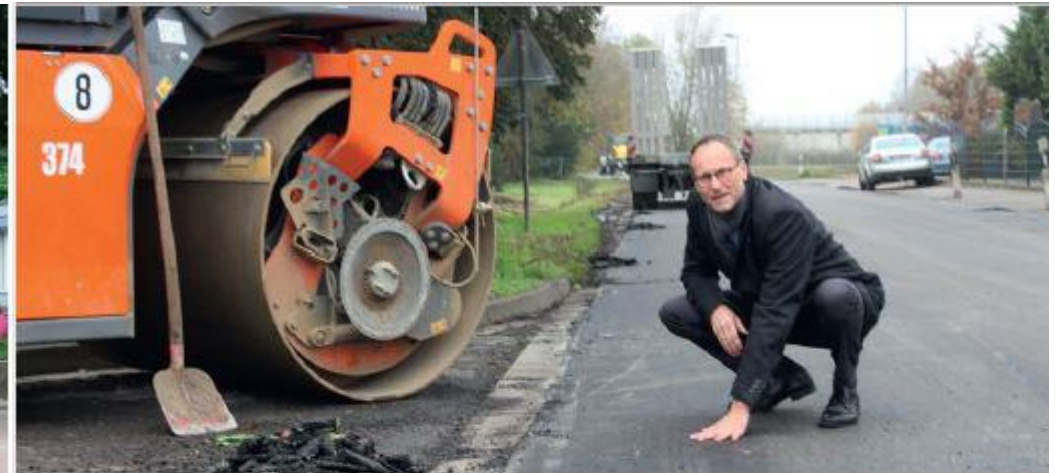
Straßensanierung in Löhne-Gohfeld
