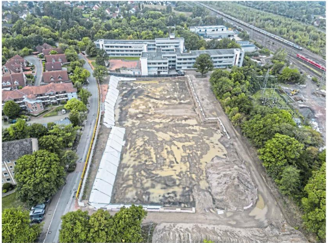
Das Luftbild zeigt die Baustelle für den Neubau des August-Griese-Berufskollegs. Dort standen vorher die Sporthallen. Im Hintergrund ist auch das alte Schulgebäude zu erkennen.
